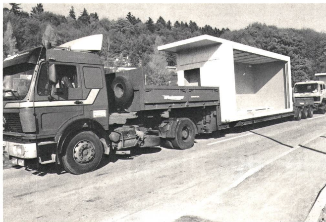
Fig. 10 Ankunft der beiden Hälften der Baracke auf der Strasse – Les deux moitiés de la baraque arrivent par la route
