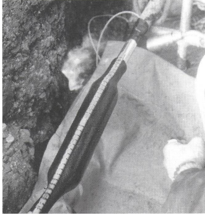
Installationen einer XAGA-500-Verbindungs- muffe
