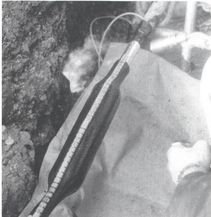
Installation einer XAGA-500-Verbindungs-muffe mit integrierter Feuchtigkeitssperre
