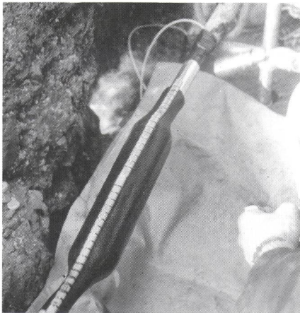
Installation einer XAGA-500-Verbindungs-muffe mit integrierter Feuchtigkeitssperre
