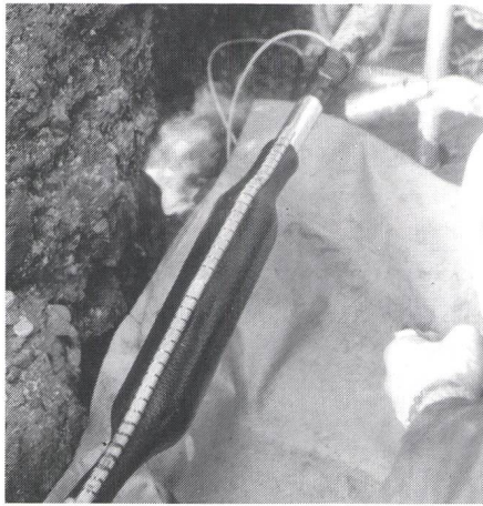
Installation einer XAGA-500-Verbindungs-muffe mit integrierter Feuchtigkeitssperre
