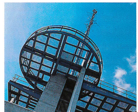
Bild 5. Blick auf eine Antennenplattform.
