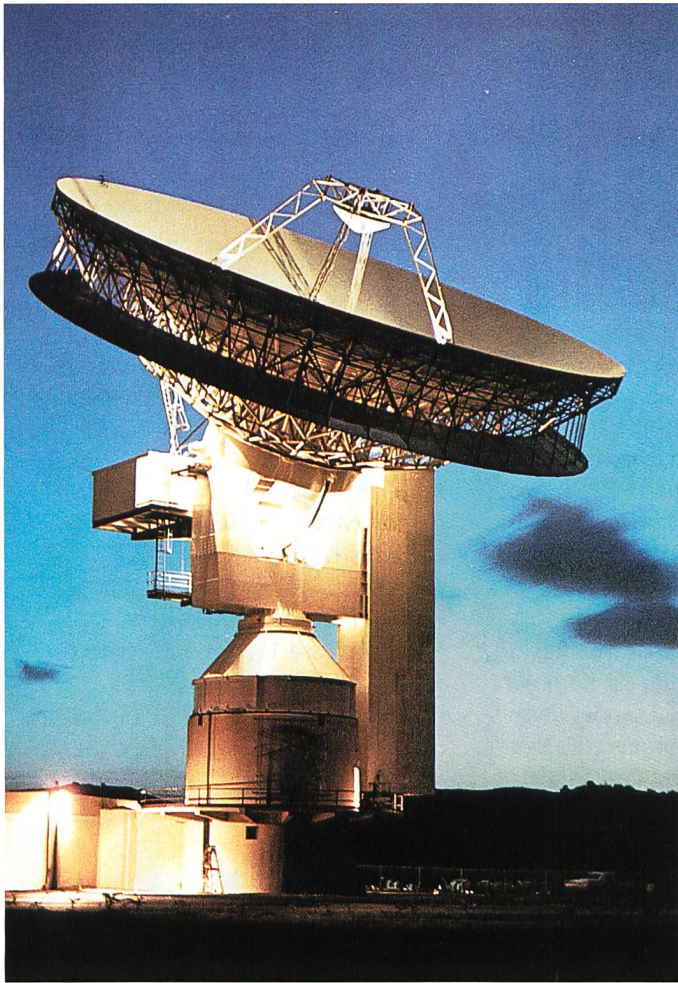
Bild 2. Bodenstation Cayey in Puerto Rico.
