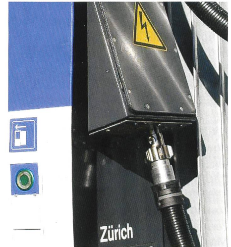
Bild 9. Verbinder zwischen zwei ICC-Wagen (ein Repeater versorgt die Antennen in mehreren ICN-Wagen).
