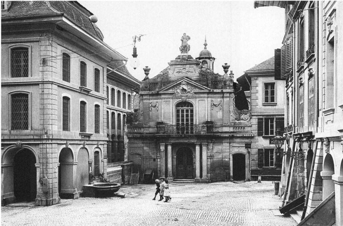
Abb. 23: Nordfassade der Bibliotheksgalerie, in welcher seit 1791 das alte Raritätenkabinet und seit 1832 das öffentliche Museum untergebracht war. Die Fassade wurde vom Architekten Niklaus Sprüngli (1725–1802) in den Jahren 1773–1775 erbaut. Sie wurde beim Abbruch der Bibliotheksgalerie 1908–1911 geschont, unter Denkmalschutz gestellt und auf Antrag des Architekten Henry Berthold von Fischer (1861–1949) als „Wasserschloss“ beim Thunplatz wieder aufgestellt (Mandach 1951, Weber 1976, Huber W. 1982, Schnell 2013). Bildquelle: Burgerbibliothek Bern. Signatur: FI Franco-Suisse 2220.
