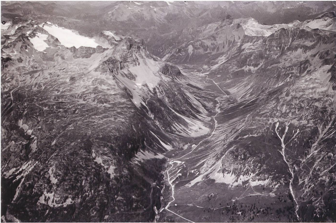
Abb. 16. Historische Flugaufnahme (1934) der Julierpassstrasse (Foto: Walter Mittelholzer, e-pics ETHZ).
