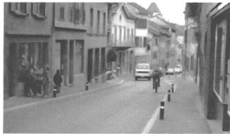
Grandson: Die Hauptstrasse, eine Kantonsstrasse mit über 6000 Fahrzeugen pro Tag, nach dem Umbau. Eine mutige Lösung, von der sich schliesslich, nach einer wissenschaftlich untersuchten Versuchsphase, auch die kantonalen Fachleute überzeugen liessen.
