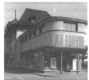
Geschäftshaus au Louvre, Reinach
