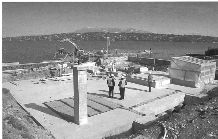
La construction de la prise d'eau dans le lac.
