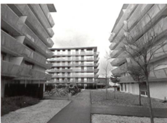
Punkthäuser auf dem Röntgenareal in Zürich
