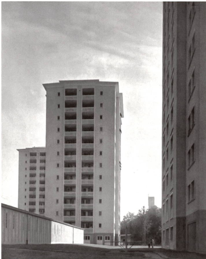
A. Gfeller, H. Mähly, Hochhäuser Entenweid I bis III, Basel, 1950/51.
