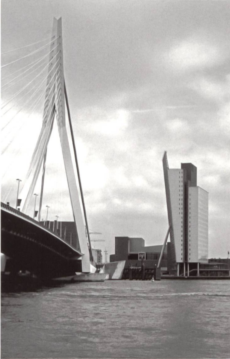
Belvedere (KPN), Office Tower mit Hotel, Rotterdam NL, Renzo Piano 1997-2000.
