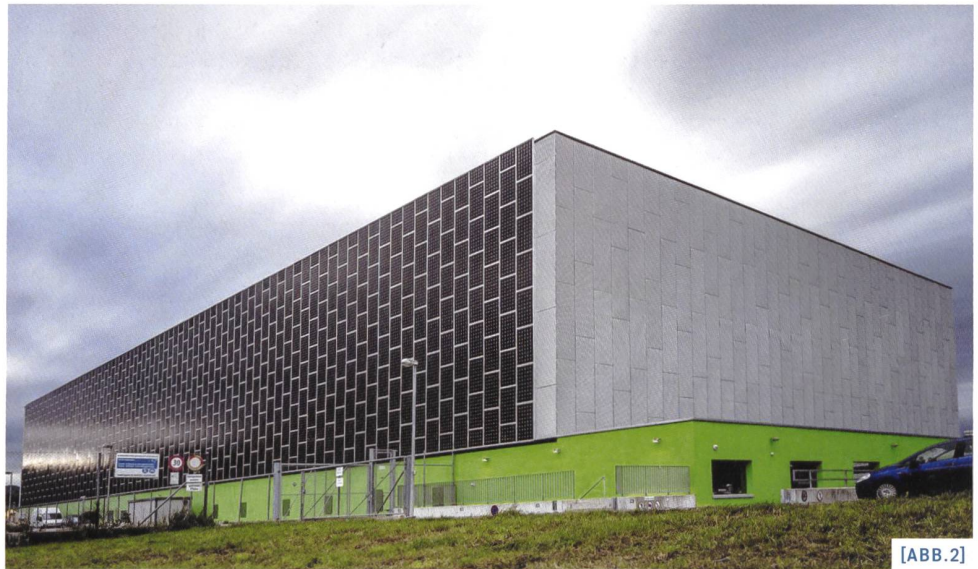
[ABB.2] Das grösste Rechenzentrum der Schweiz steht im Aargau. (Foto: Philipp Schmidli/Green.ch)
