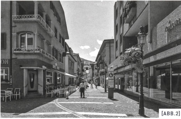
[ABB.2] In Visp VS ist es gelungen, eine zentrale Fussgängerzone zu realisieren. (Quelle: Fussverkehr Schweiz, 2017)
