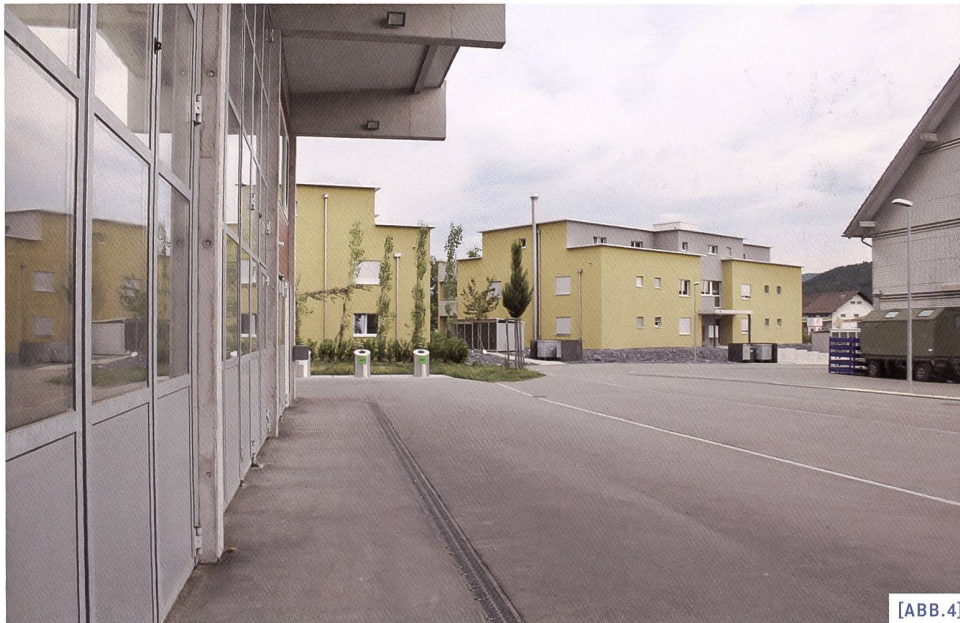
[ABB.4] Entsorgungsanlage, Weiach; platzartige Erweiterung im Transformationsgebiet: hier hat die Gemeinde auch schon das 1. August-Fest durchgeführt
