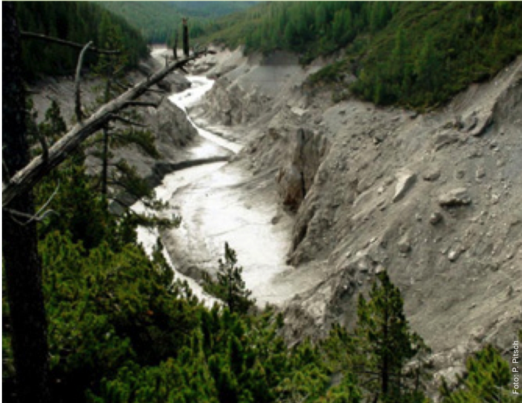
Abbildung 5 Blick in das geleerte Ausgleichsbecken Ova Spin mit beachtlichen Ablagerungen auf der Talsohle.
