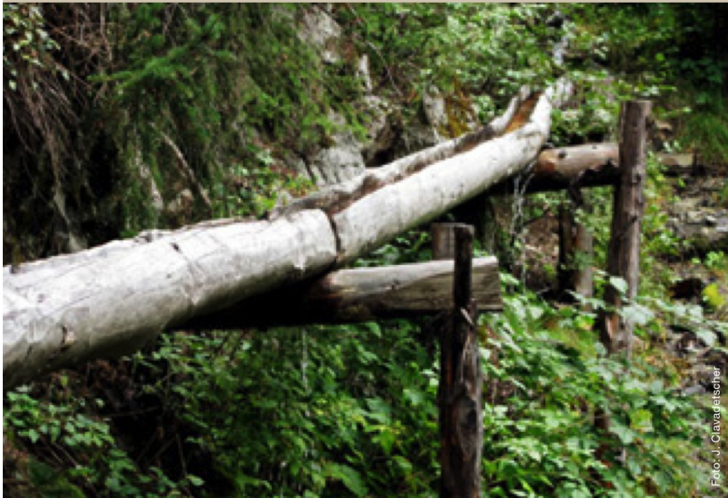
Bei der Fassung des Aual Foppumvasch wurden neue Holzkanäle installiert.
