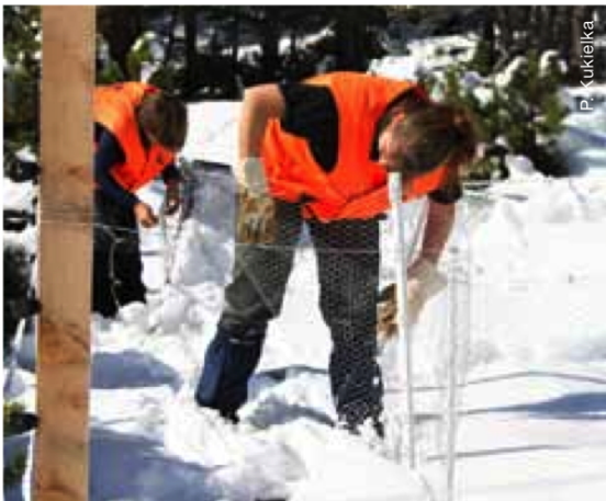
Reparaturarbeiten an Zäunen nach Wintereinbruch.
