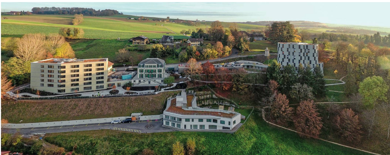
Mariage réussi entre tradition et modernisme, grâce à All IP: le siège social de la Fondation Saphir, à Bellevue, Yverdon-les-Bains
