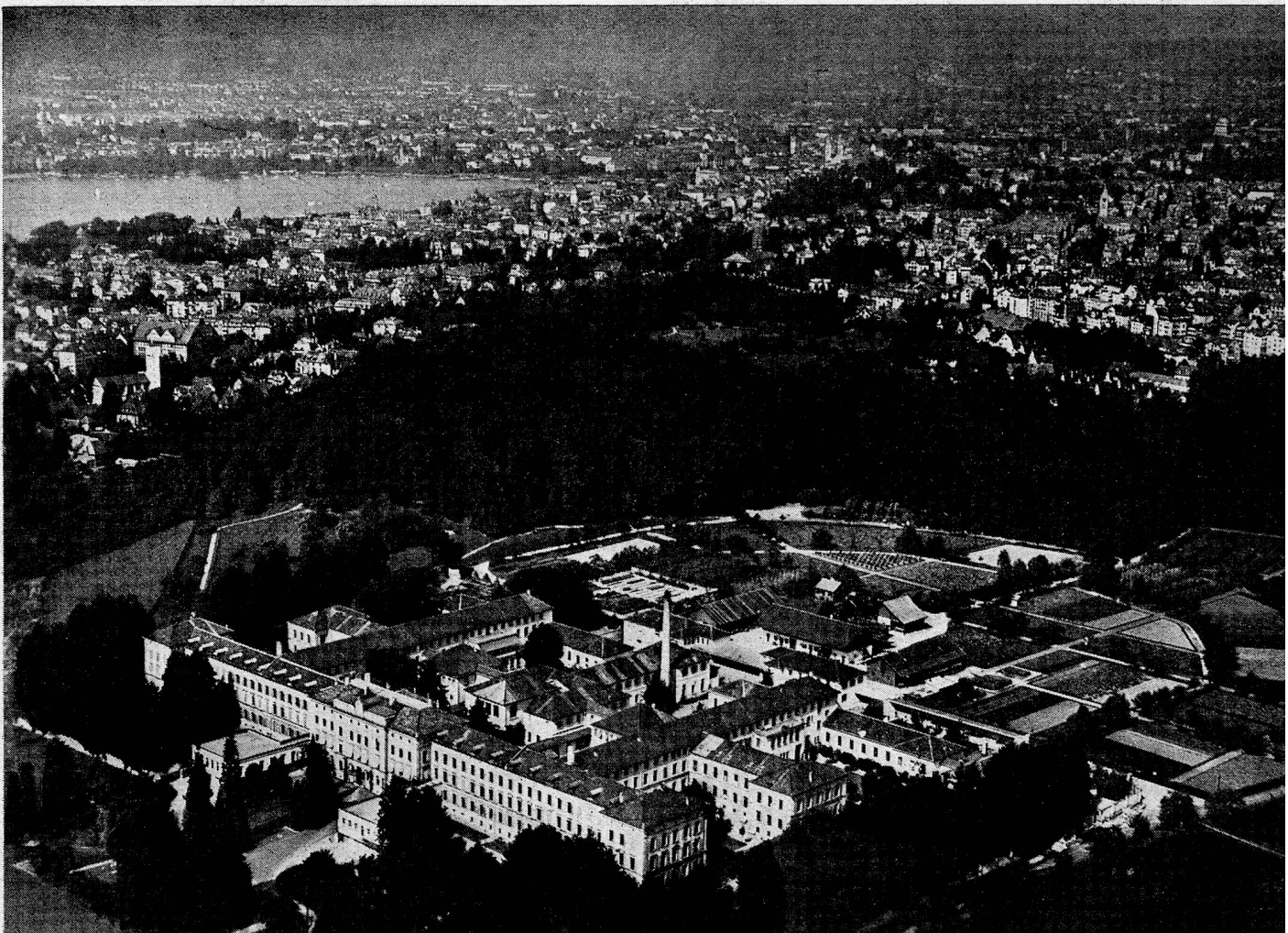
Kantonale Heilanstalt Burghölzli, Zürich 8
