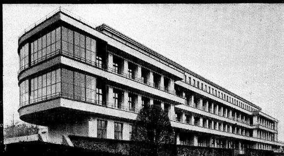
Inselspital Bern Selbsttätige Heizregelanlage System Landis & Gyr
