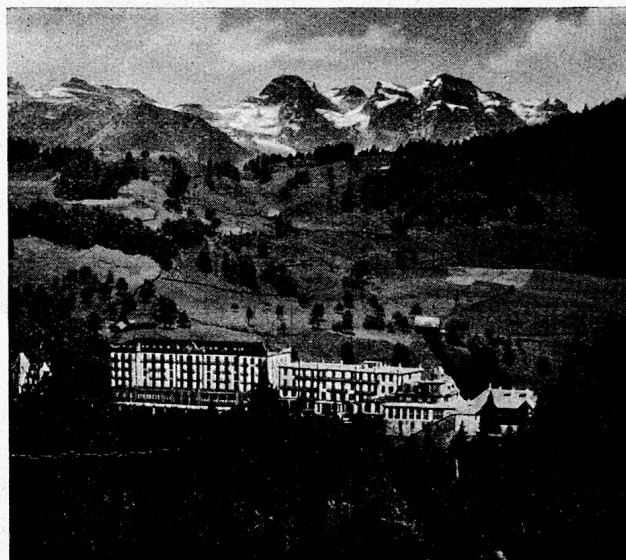
Palace- und Parkhotel mit Blick gegen die Alpen
