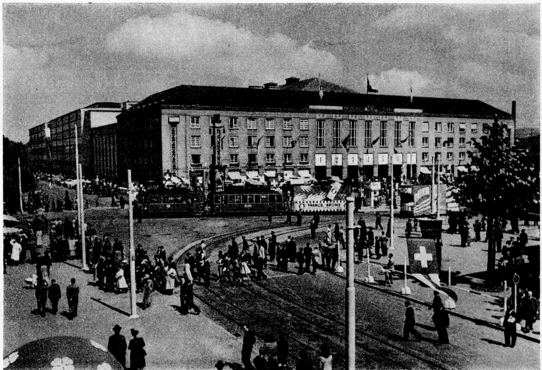
Das Basler Mustermessegebäude mit Blick auf die Hallen IIb und IIIb
