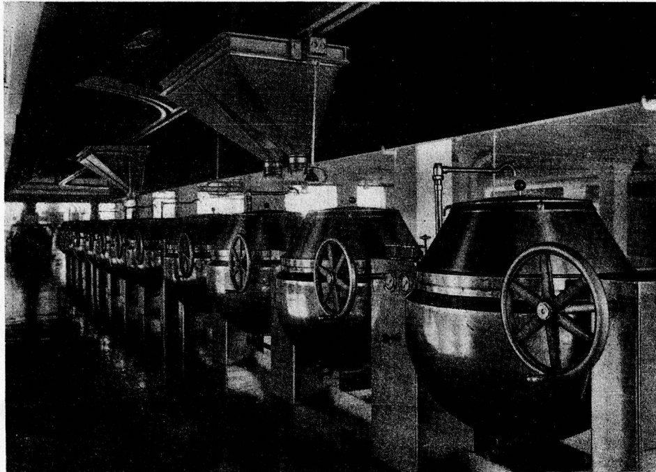
Eine Batterie von Kochkesseln aus rostfreiem Stahl, zum Kochen der ROCO-Confitüre nach Hausmacherart. An der Decke laufen die Zuführungswagen mit dem Zucker.
