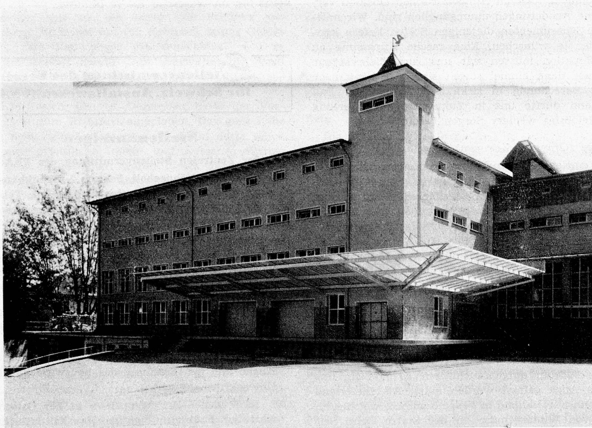
Die neue ROCO-Confiturenfabrik von der Hofseite gesehen.
