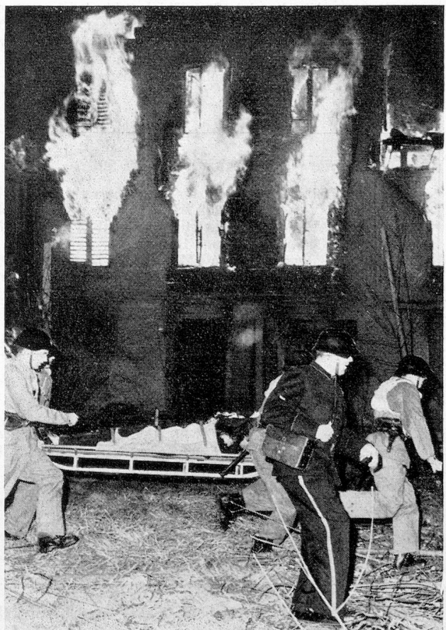
Abtransport eines Verletzten mit einem Rettungsschlitzen zum Sanitätsposten.
