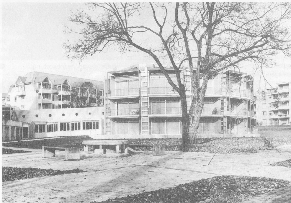
Alterswohnheim Am Wildbach, Wetzikon
