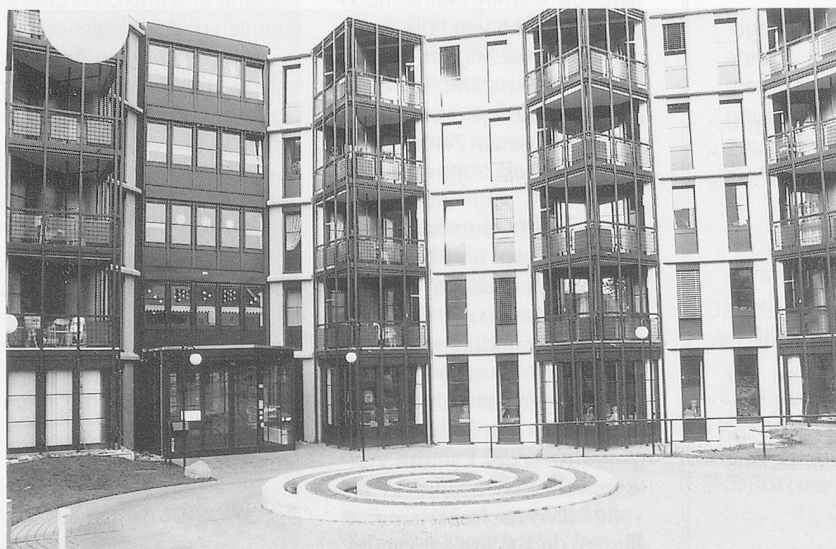
Eingang zum Altersheim St. Urban, Winterthur-Seen.
