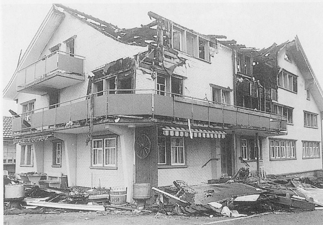
Das Altersheim Oberegge nach dem Vollbrand vom 14. April 1994.
