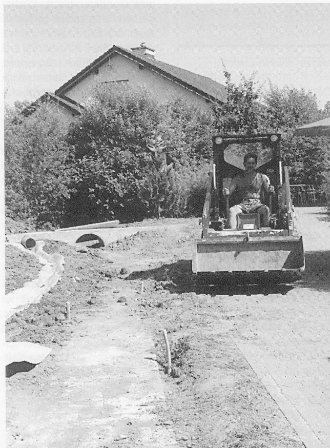
Zirka 10 Kubikmeter Beton wurden für das Gleisfundament und für Brücken verarbeitet.
