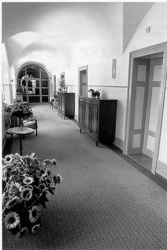
Dank des Teppichbodens in den Korridoren wird der Trittschall wesentlich gedämpft.
