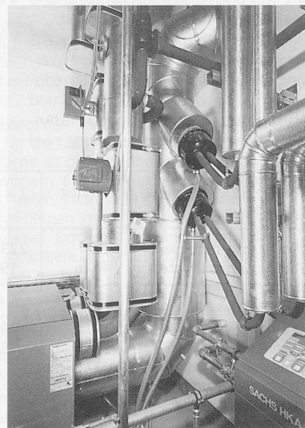
Von links nach rechts: Der Spitzenkessel mit Gas/Öl-Zweistoffbrenner. Auch der Speicher findet noch im Heizraum Platz (hinten eines der Mini-BHKWs). Einfache, durchdachte Vermeidung von Körperschall-Übertragung: Gesteckte Abgasrohre, flexible Schläuche, isolierte Rohrschellen.
