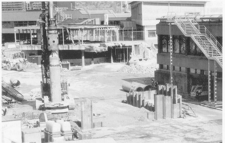
... oder ein Bauplatz, wie der Flughafen Zürich?
