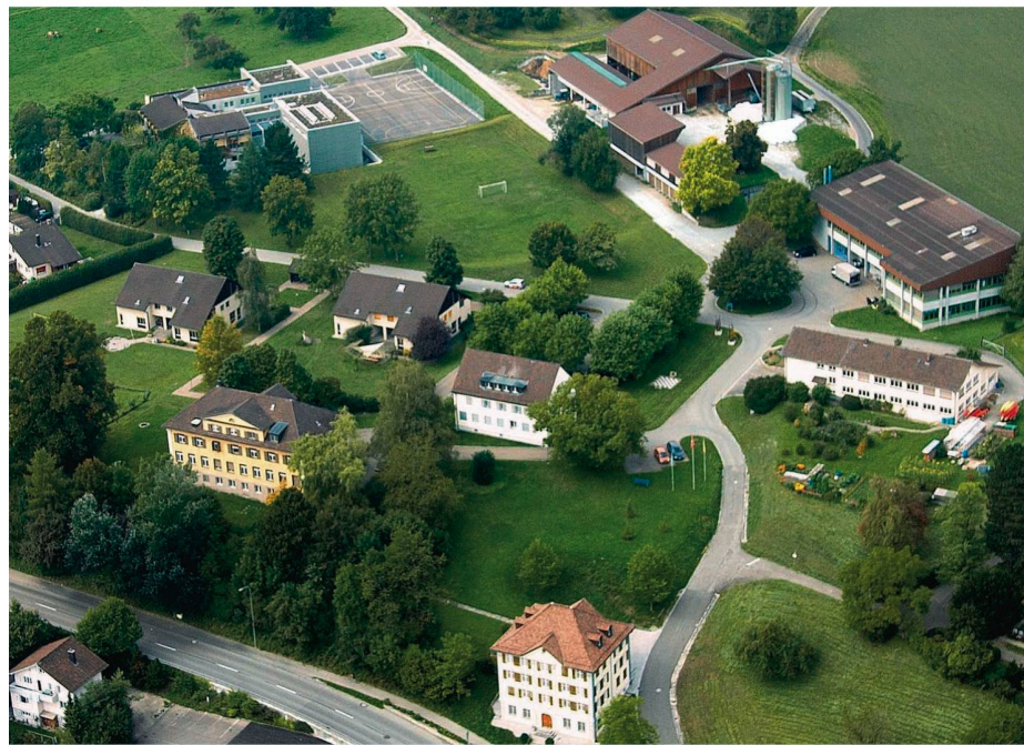
Die Häusergruppe des Jugendheims Platanen Hof liegt idyllisch auf einer Anhöhe bei Oberuzwil.
