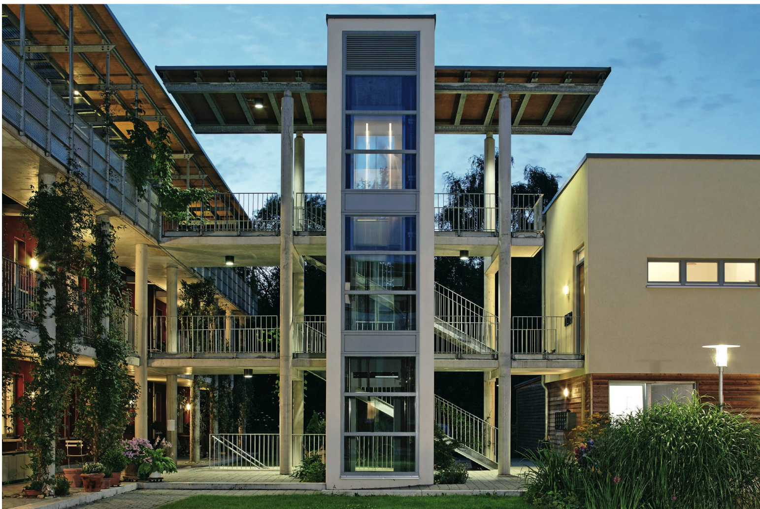
Barrierefreie Wohnsiedlung mit zentralem Lift und Laubengängen in Dortmund (Post/Welters Architekten & Stadtplaner, Dortmund): Es brauchte eine lange Zeit, bis die Anliegen der Behinderten in der Mitte der Gesellschaft ankamen. Foto: Cornelia Suhan
