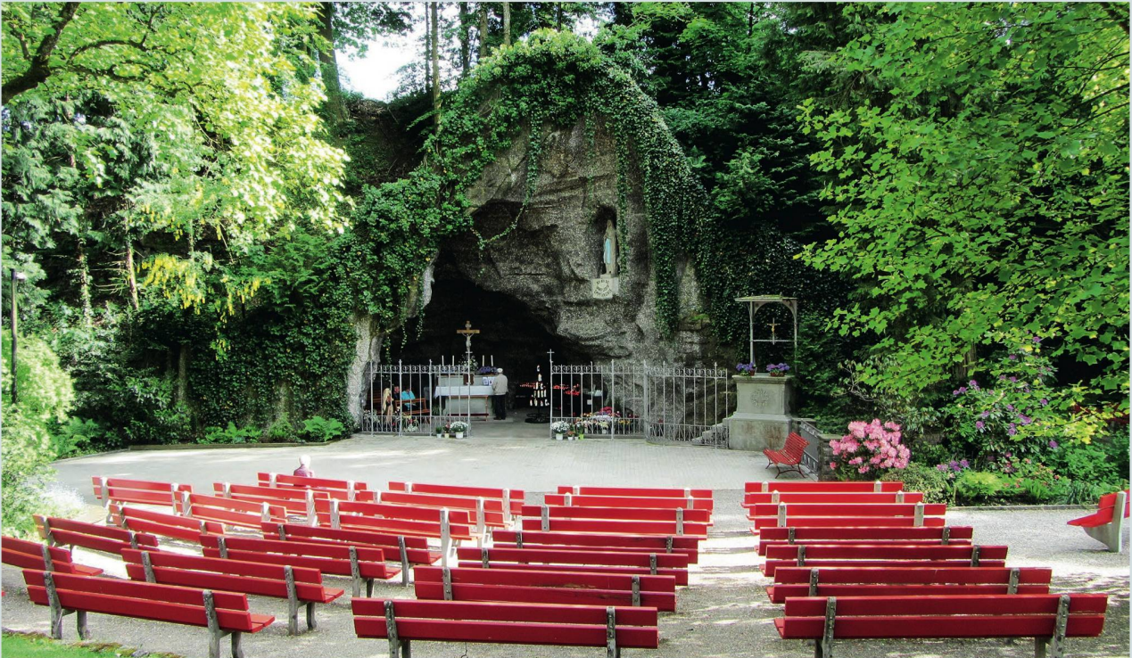
Lourdes-Grotte in Leuggern AG: Kopie aus Spritzbeton.
