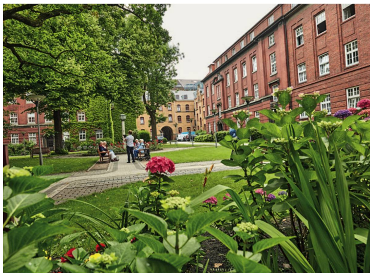
In den Gebäuden der Heerlein- und Zindler Stiftung Hamburg: Neue Demenz-Pflegegemeinschaft Foto: Hartwig-Hesse-Stiftung
