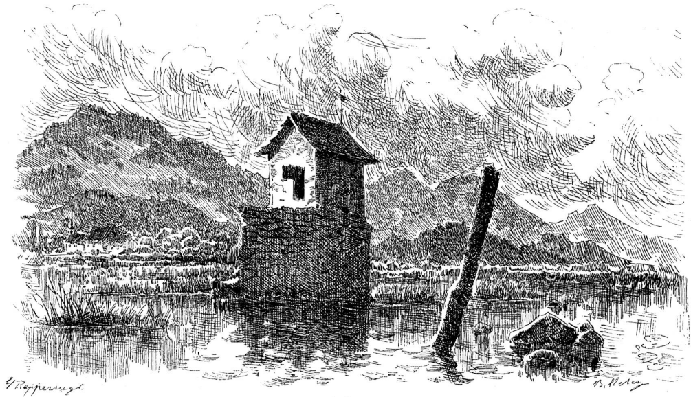
Rapperswil: Der alte Brückenkopf.
