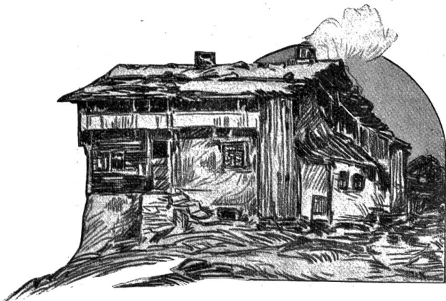
Ein Bündnerhaus (b. Disjantis.)
