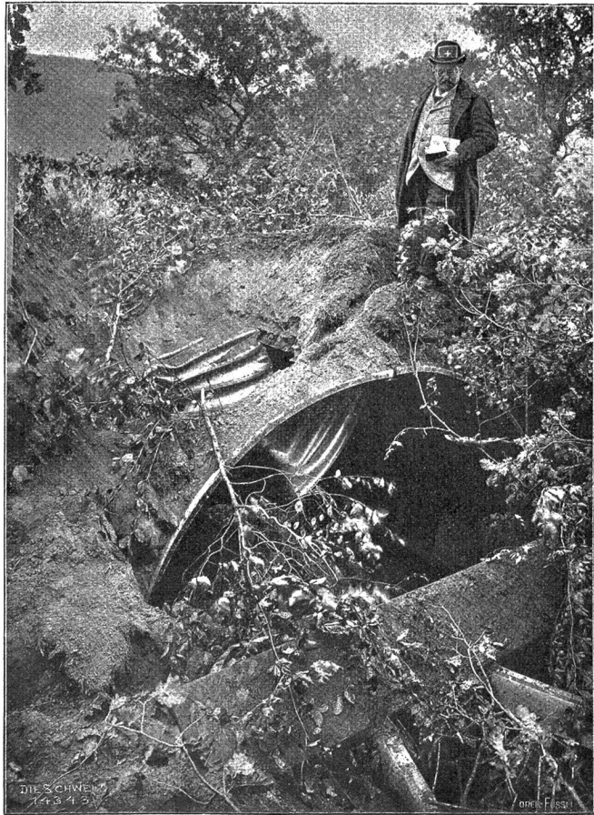
Befestigung am Zibhkanal: Wirkung einer 12 cm Granate auf geschützte Infanterie-Unterstände (Phot. A. Krenn, Zürich).
