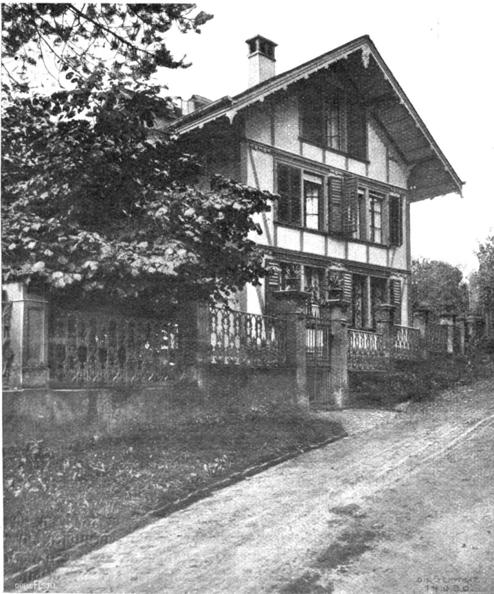
Wohnhaus Max Schneckenburgers in Burgdorf, wo Ende 1840 die „Wacht am Rhein“ entstand.
