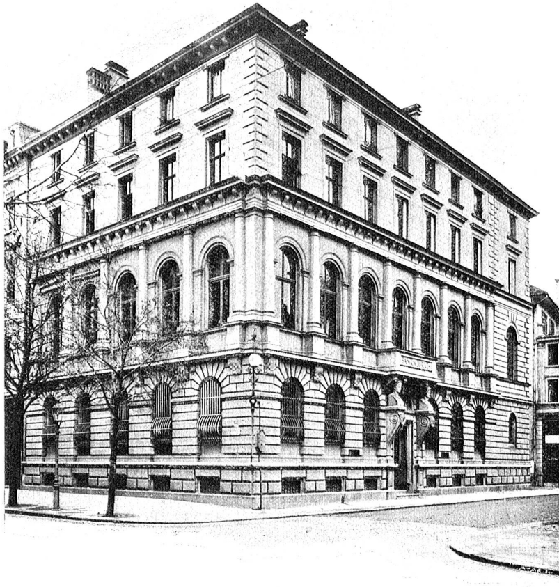
Die künftige eidgenössische Bundesbank an der Bahnhofstraße in Zürich.
