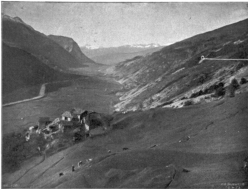
Von der Lötschbergbahn. Blick von der im Bau befindlichen Strecke ob Maron gegen das Unterwallis bis Sitten.
