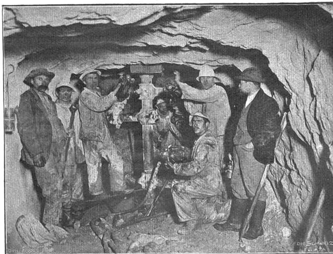
Von der Lötschbergbahn. Ingersoll-Bohrmaschine in Tätigkeit „vor Ort“.
