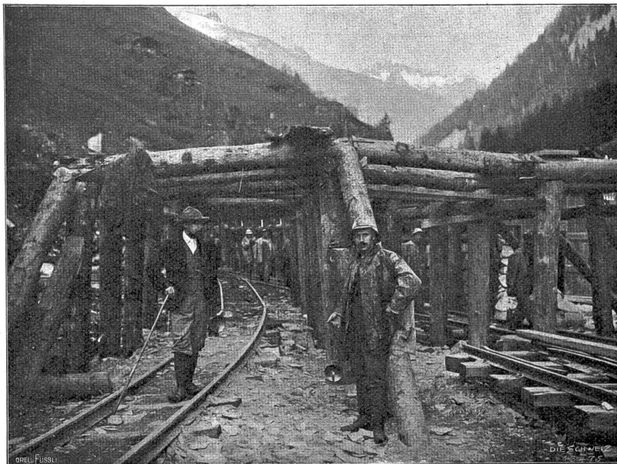
Von der Eötschbergbahn. Lawinenschutzbauten am Südausgang des Eötschbergtunnels bei Goppenstein.
