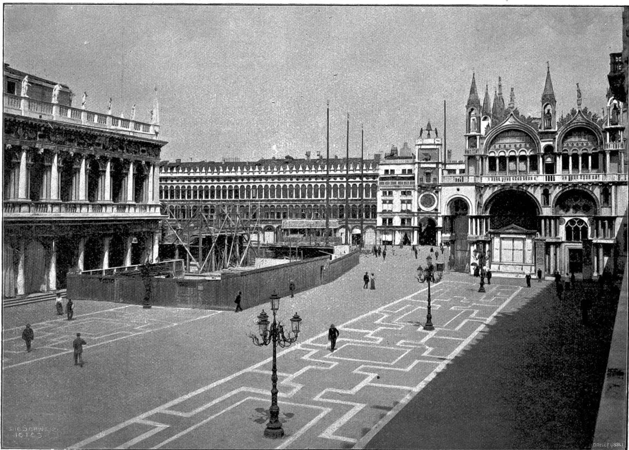
Vom Schicksal des Campanile von Venedig. Der Markusplatz mit dem Baugerüst.
