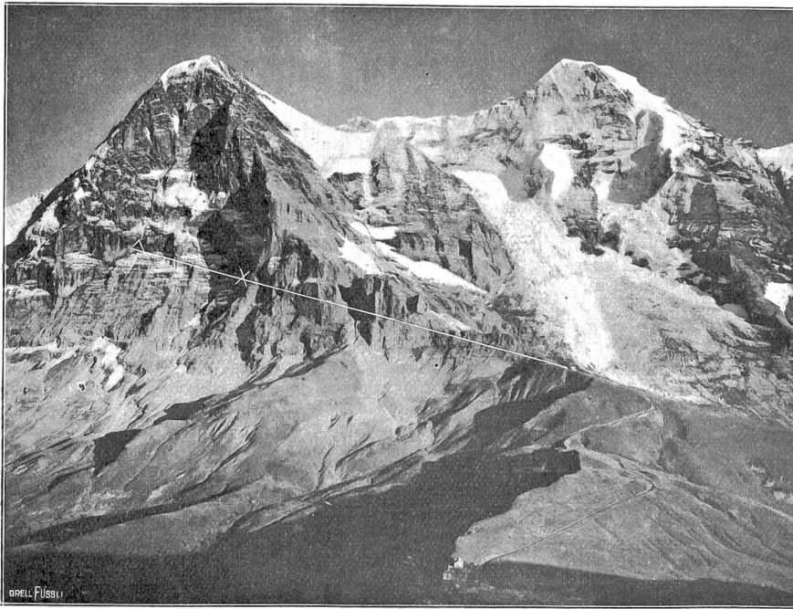
Eiger und Mönch mit der Explosionsstelle \times des Dynamitlagers der Jungfraubahn. Weiter oben Station Eigerwand \triangle . (Phot. A. Krenn, Zürich)
