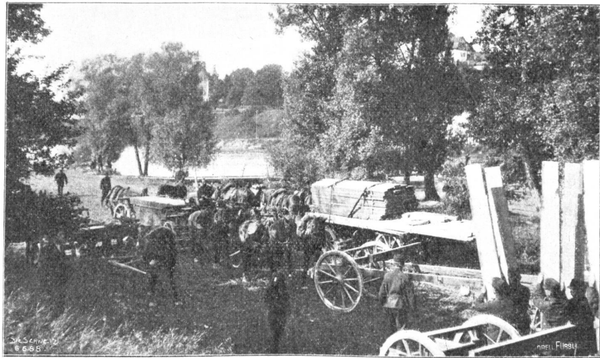
Militärischer Brückenbau bei Flurlingen, Schaffhausen. Parkplatz. Phot. C. Koch, Schaffhausen.
