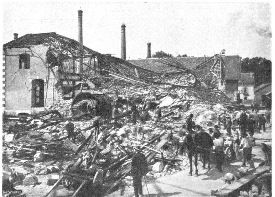
Explosion in Genf. Die zerstörten Laboratorien und Gasreinigungsgebäude. In der Mitte der Standort-Wäscheapparat, die mutmaßliche Epplionsstelle. Phot. Anton Krenn, Zürich.
